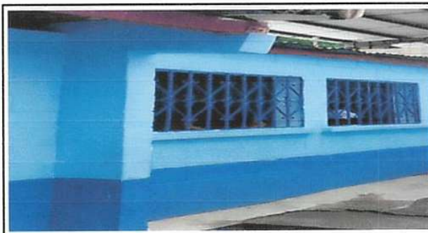
Foto 4: como se puede observar no cuenta con ventanas
