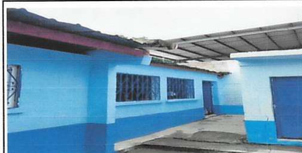
Foto 6: como se puede observar se necesita canal con bajada de agua pluvial
